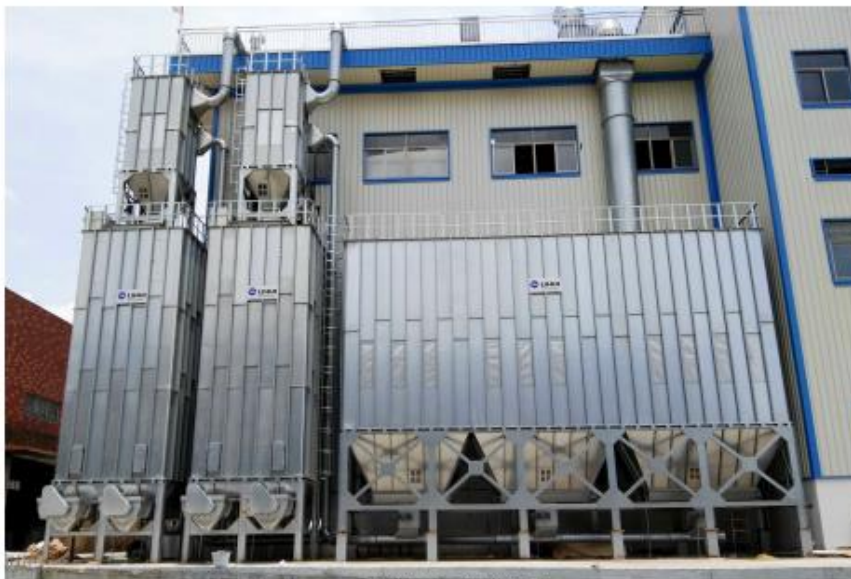
LHYD 圆袋除尘系统实例图
