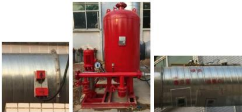
风管火花探测及熄灭装置案例图
